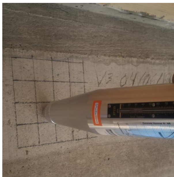
b) Ensaio esclerométrico sendo realizado na demarcação
