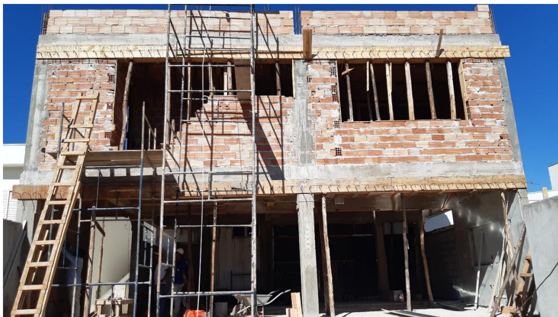
Figura 1 - Estado da obra em junho de 2019.
