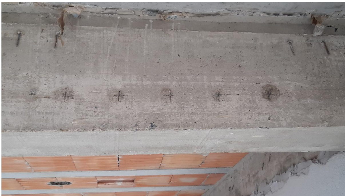
Figura 14 - Marcação dos pontos no elemento de concreto.
