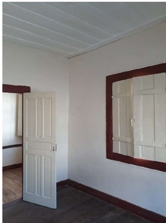
Figura 35 – Vista interna da fachada restaurada, eixo 2
