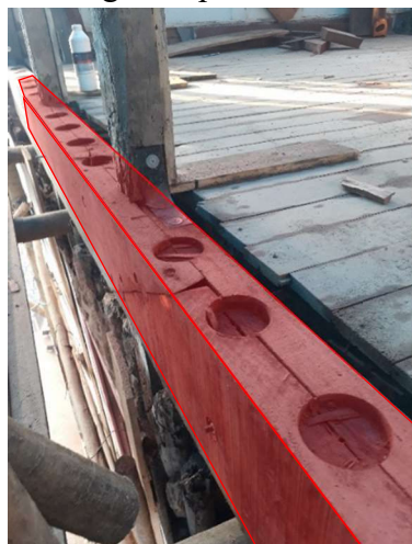
Figura 21 – Nova madre do segundo pavimento
