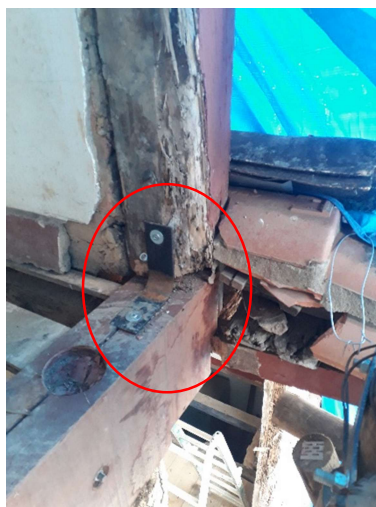
Figura 22 – Chapa metálica e barra roscada
