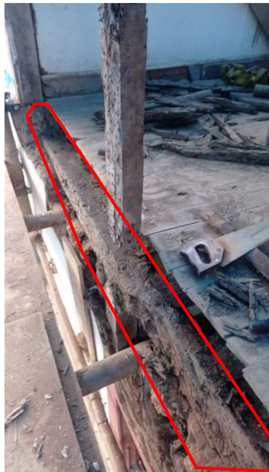
Figura 16 – Madre de piso do segundo pavimento
