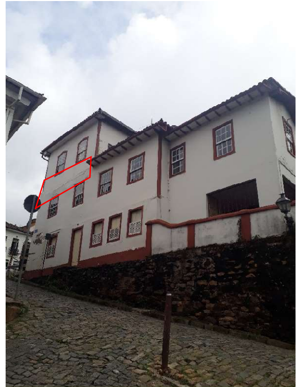
Figura 8 – Fachada lateral direita
