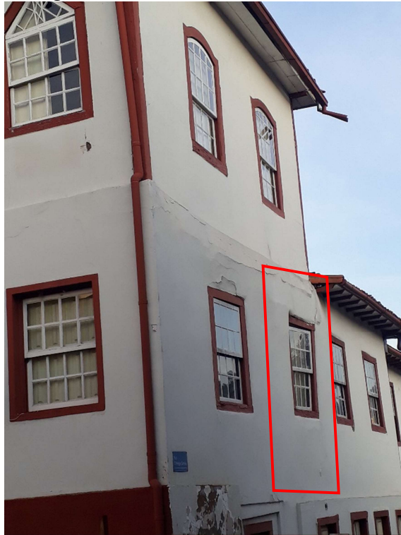
Figura 10 – Detalhe da fachada lateral rua Conego Simões
