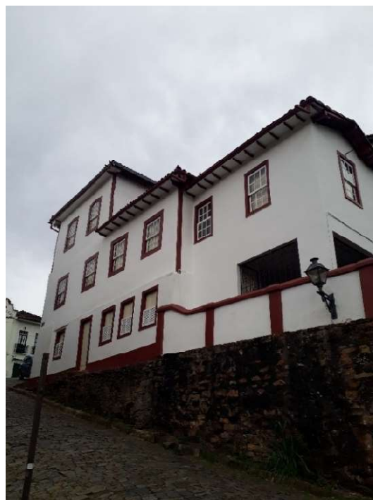
Figura 33 – Fachada rua Cônego Simões trecho restaurado
