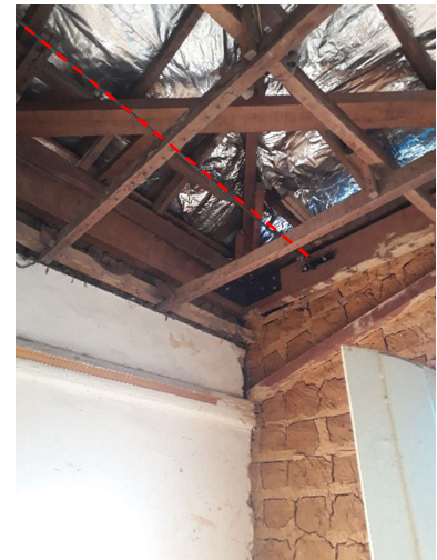
Figura 31 – Cabo de aço instalado no telhado, eixo 3
