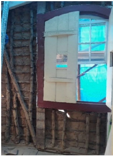
Figura 17 – Parede de pau a pique desmontada
