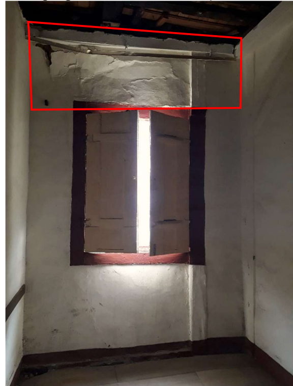
Figura 11 – Vista interna da fachada lateral destaque para trecho com variação vertical
