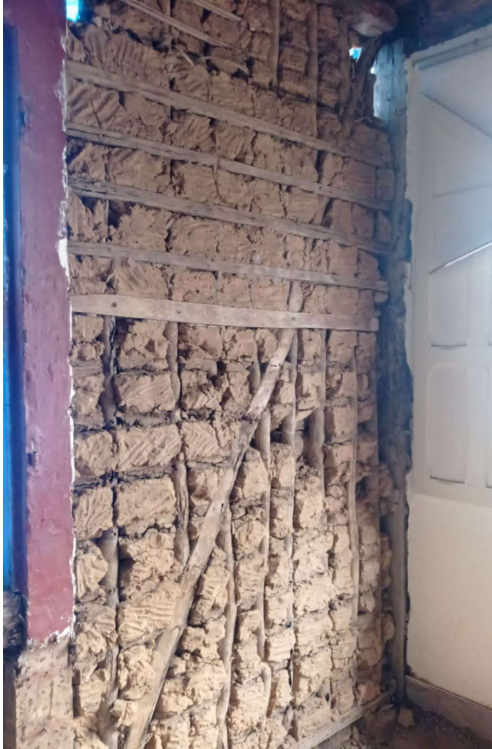
Figura 13 – Pau a pique do primeiro pavimento existente
