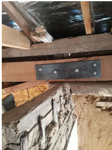
Figura 30 – Reforço com chapa de aço 3/8"
