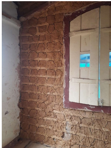
Figura. 26 – Trama de pau a pique preenchida com barro
