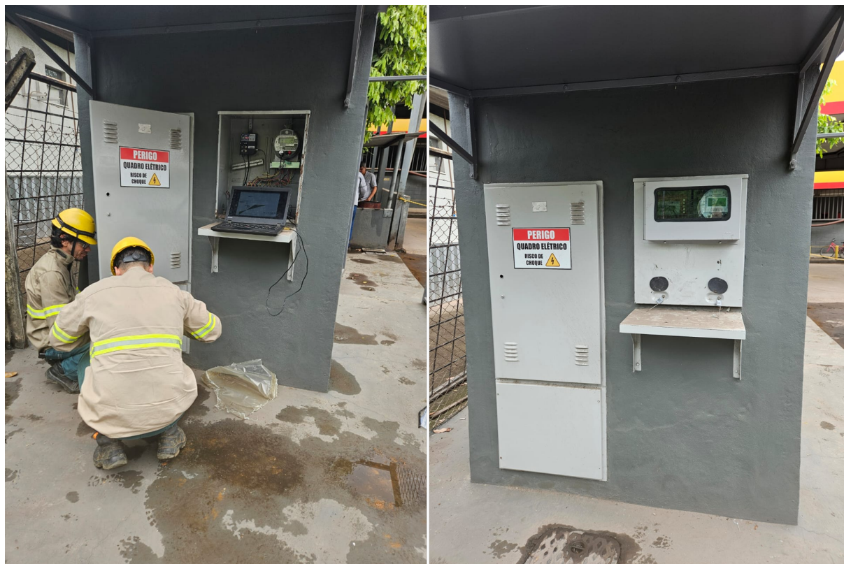
Figura 9 – Equipe Cemig instalando o medidor CCEE e a tampa adaptadora da caixa cm4
