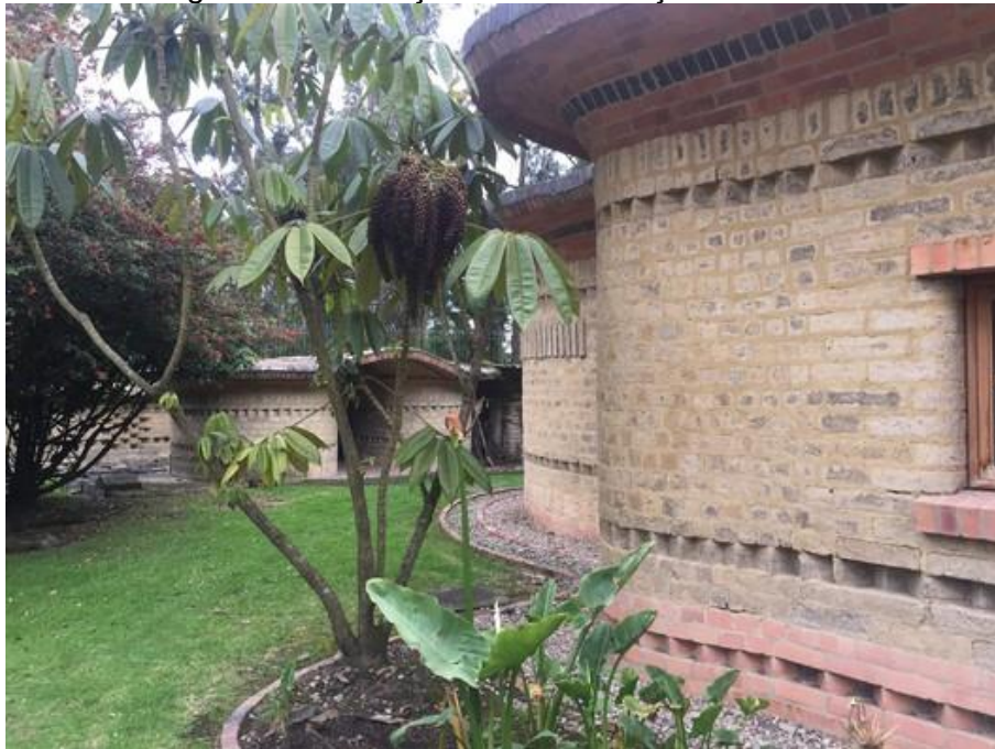
Figura 5 – Edificação com a utilização de adobe
