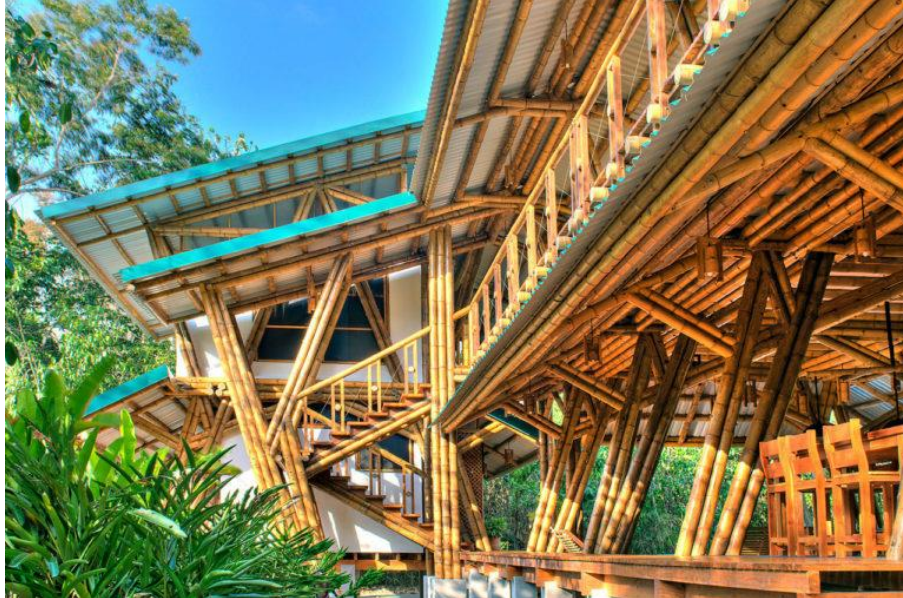
Figura 3 – Construção com uso de bambu
