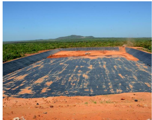
Figura 6 – Aterro sanitário em Palmas/TO
