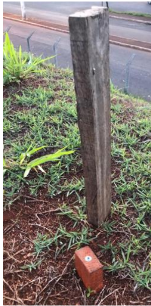
Figura 5 – Estacas e piquetes.
