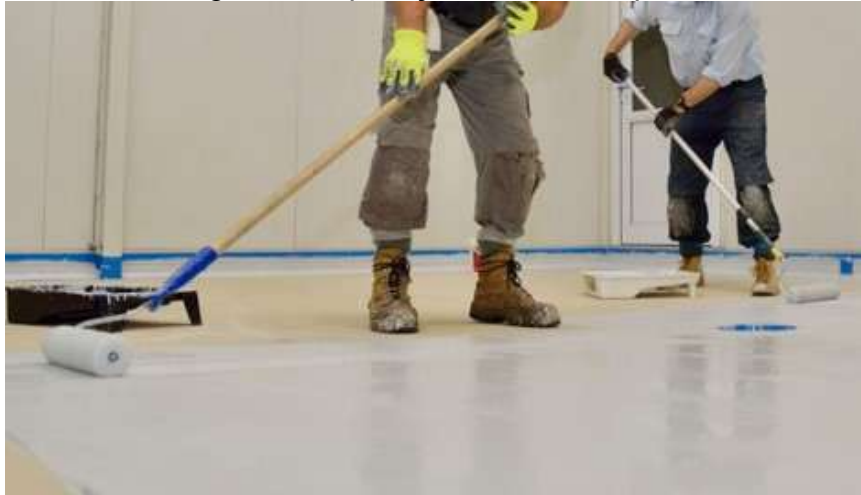
Figura 1 - Aplicação de resina epóxi
