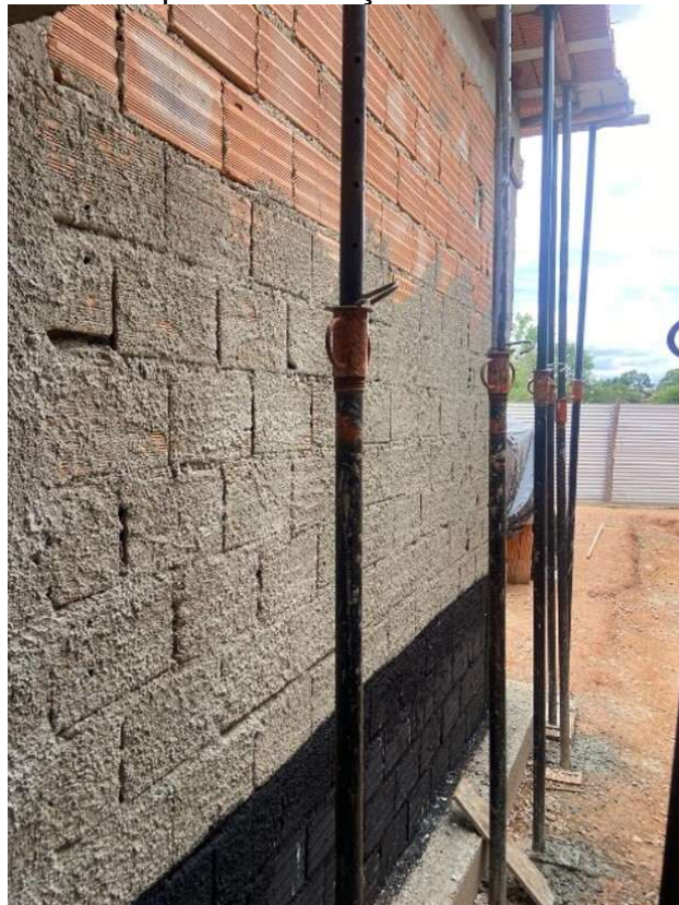
Figura 21 - Impermeabilização da Alvenaria Externa
