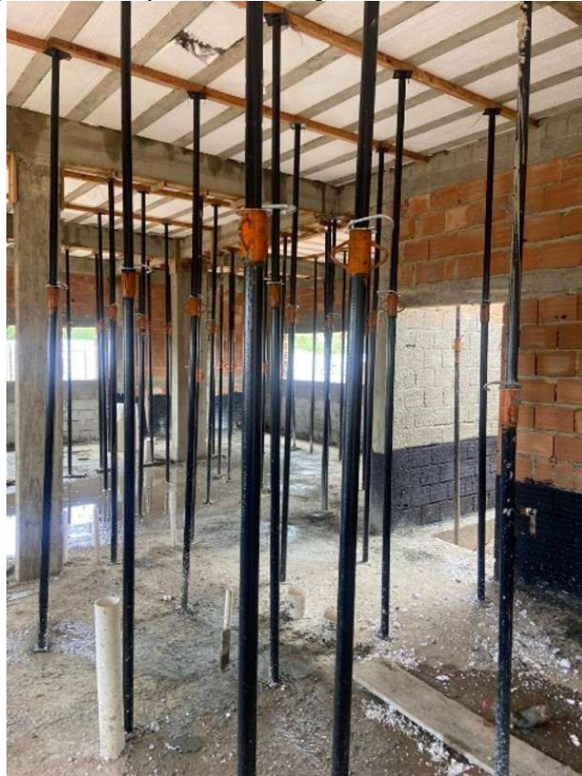
Figura 20 - Impermeabilização da Alvenaria Interna
