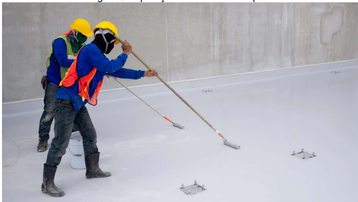
Figura 8 - Aplicação de Membrana Líquida
