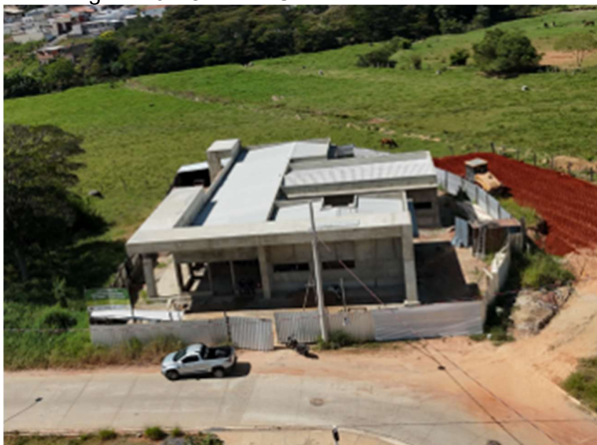
Figura 10 - Obra de Unidade Básica de Saúde
