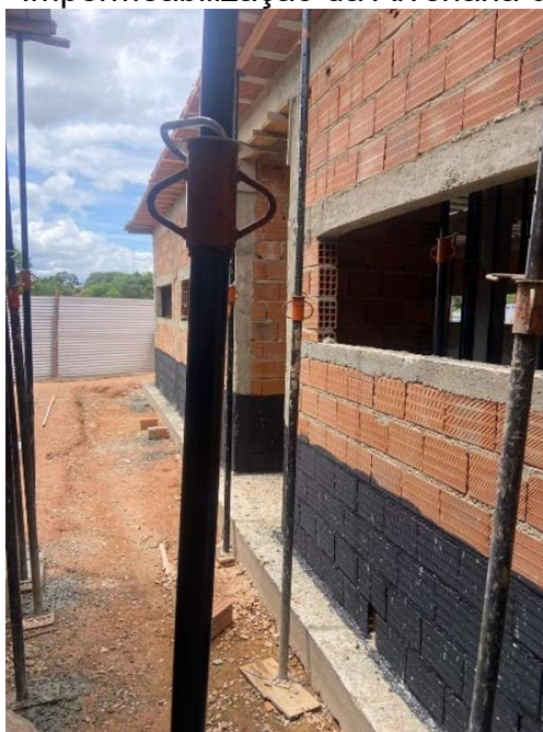
Figura 22 - Impermeabilização da Alvenaria de Vedação
