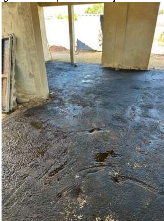
Figura 25 - Impermeabilização do Radier
