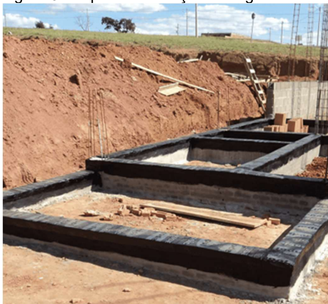
Figura 9 - Impermeabilização de Viga Baldrame
