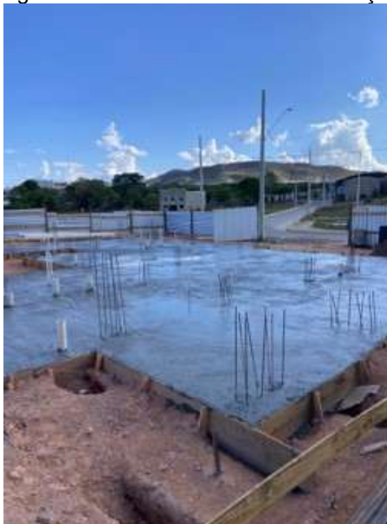
Figura 23 - Radier da Obra em Execução
