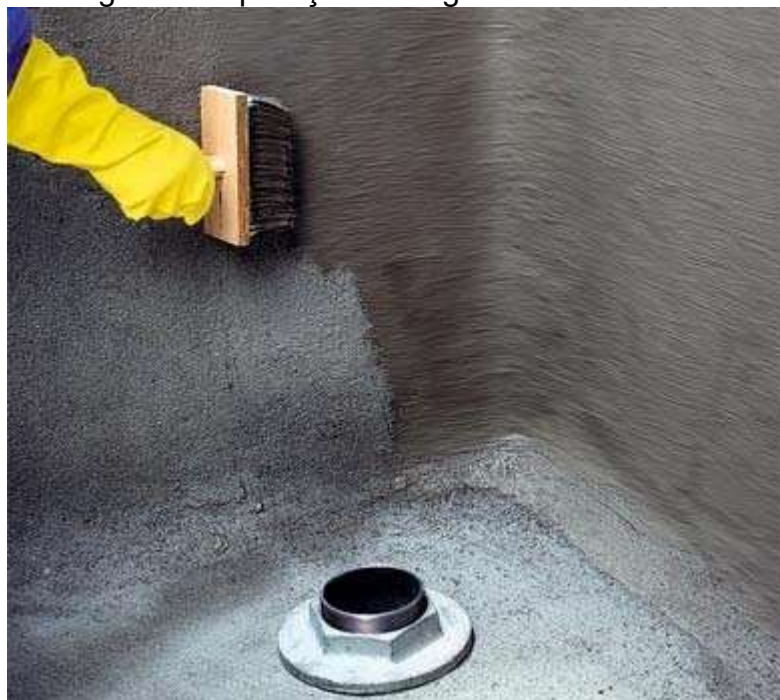
Figura 2 - Aplicação de Argamassa Polimérica
