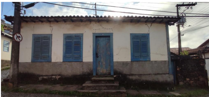
Figura 11: Situação do imóvel localizado na rua Rezende, nº 80, em 2022. Disponível em: Acervo particular. Data: 13 de Mar. de 2022.
