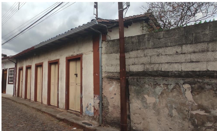
Figura 10: Situação do imóvel localizado na rua Maciel, nº 27, em 2022. Disponível em: Acervo particular. Data: 13 de Mar. de 2022.
