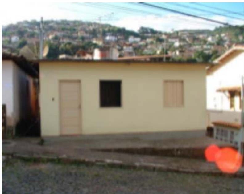
Figura 44: Fachada do Imóvel em 2002. Fonte: Inventário INBI-SU. Data: 12 Abr. 2002.
