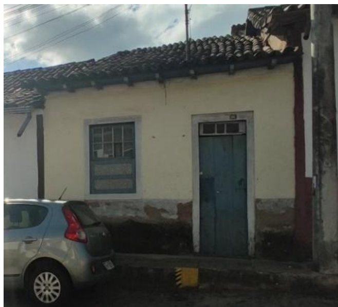
Figura 25: Fachada do Imóvel em 2022. Fonte: Acervo particular. Data: 12 de Ago. 2022.
