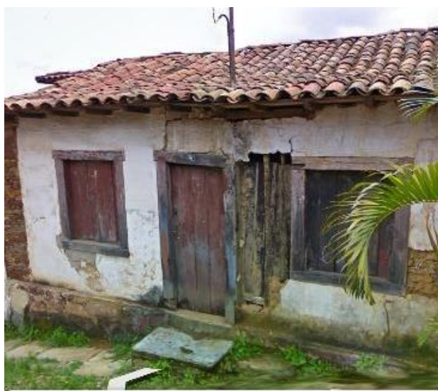
Figura 16: Situação do imóvel localizado na rua Santa Efigênia, nº 56, em 2009. Disponível em: Google Maps. Data: Nov. 2009.
