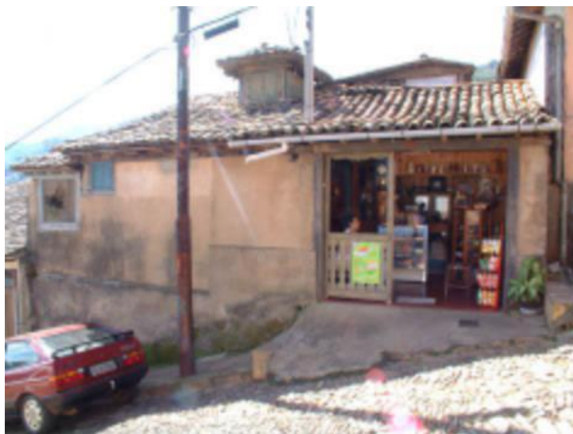
Figura 50: Fachada do Imóvel em 2002. Fonte: Inventário INBI-SU. Data: 12 abr. 2002.
