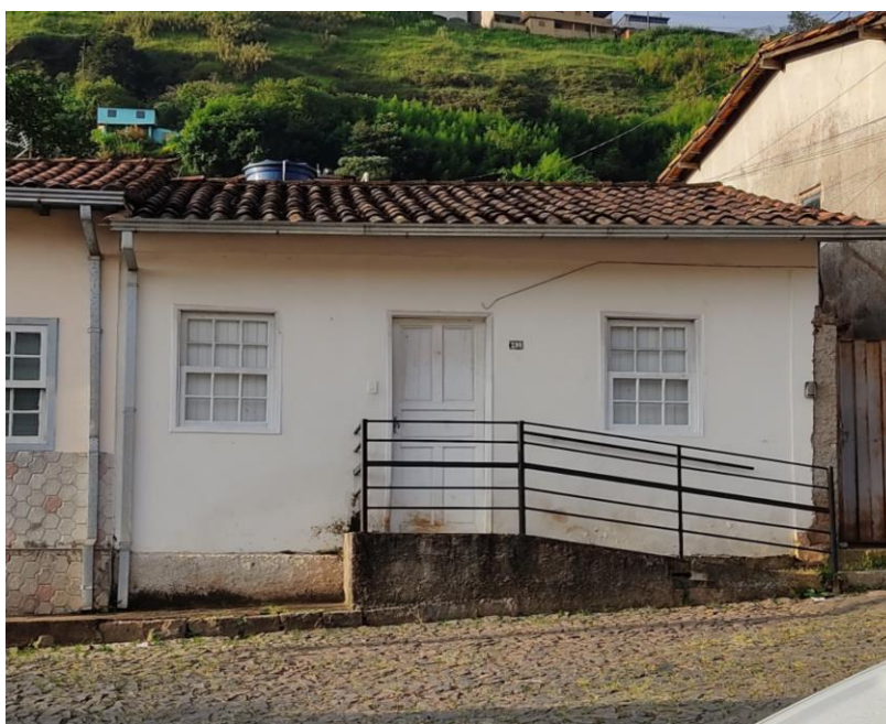
Figura 43: Fachada do Imóvel em 2022. Fonte: Acervo particular. Data: 12 Mar. 2022.
