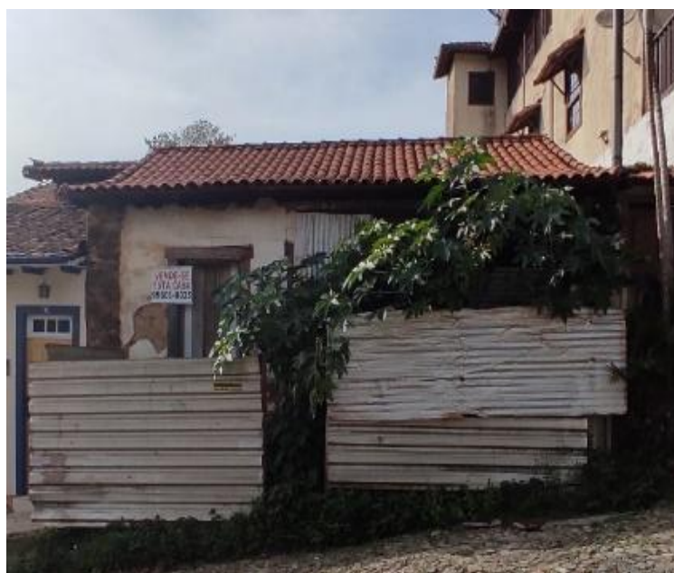
Figura 17: Situação do imóvel localizado na rua Santa Efigênia, nº 56, em 2022. Disponível em: Acervo particular. Data: 24 de Nov. 2021.
