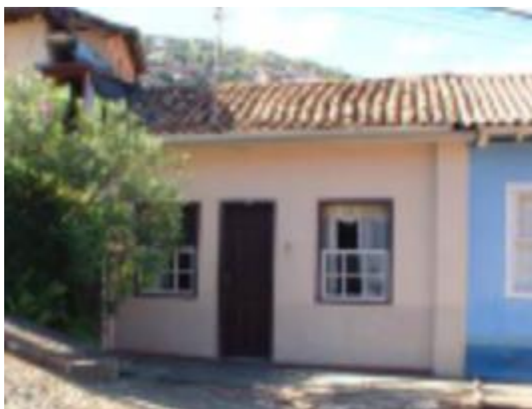
Figura 48: Fachada do Imóvel em 2002. Fonte: Inventário INBI-SU. Data: 12 abr. 2002.
