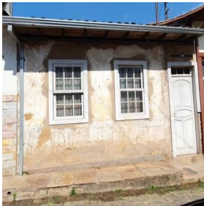
Figura 27: Fachada do Imóvel em 2022. Fonte: Acervo particular. Data: 7 de Ago. 2022.
