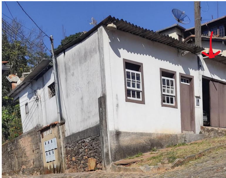
Figura 35: Fachada do Imóvel em 2002. Fonte: Acervo digital INBI-SU. Data: 23 de Nov. 2021.
