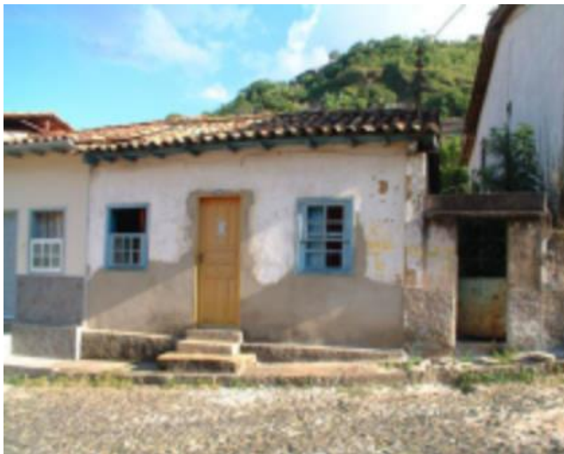
Figura 42: Fachada do Imóvel em 2002. Fonte: Inventário INBI-SU. Data: 12 abr. 2002.
