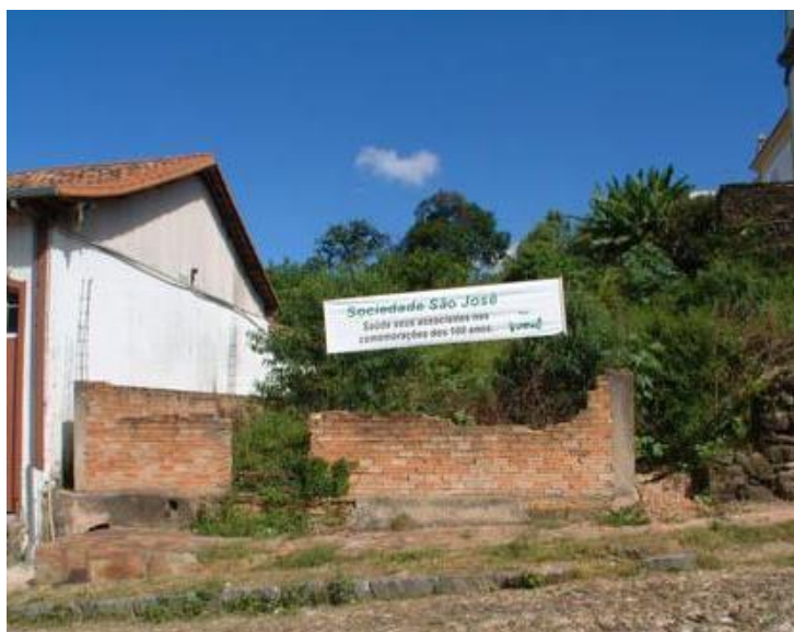
Figura 40: Início das construções em 2002. Fonte: Inventário INBI-SU. Data: 31 Mar. 2002.
