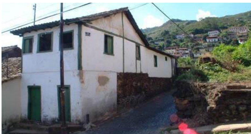
Figura 32: Fachada do Imóvel em 2002. Fonte: Acervo digital INBI-SU. Data: 13 de abr. 2002.
