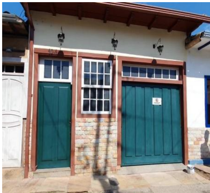
Figura 28: Fachada do Imóvel em 2022. Fonte: Acervo particular. Data: 07 de Ago. 2022.
