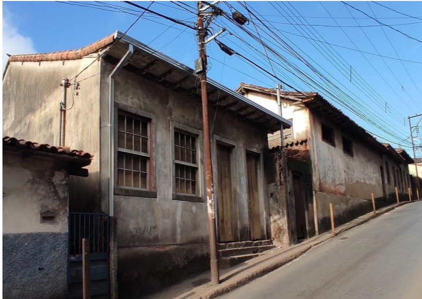
Figura 08: Situação do imóvel localizado na rua Maciel, s/n, em 2022. Disponível em: Acervo particular. Data: 24 de Mar. de 2022.
