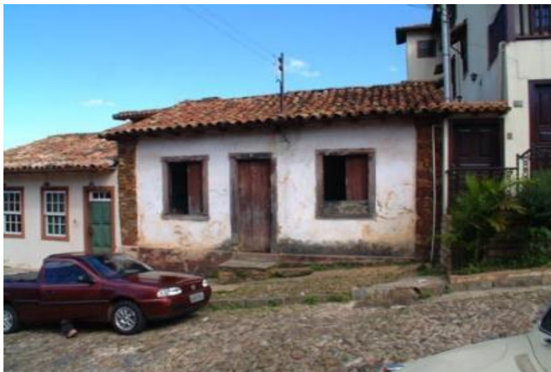
Figura 15: Situação do imóvel localizado na rua Santa Efigênia, nº 56, em 2002. Disponível em: Inventário INBI-SU. Data: 31 de Mar. de 2002.
