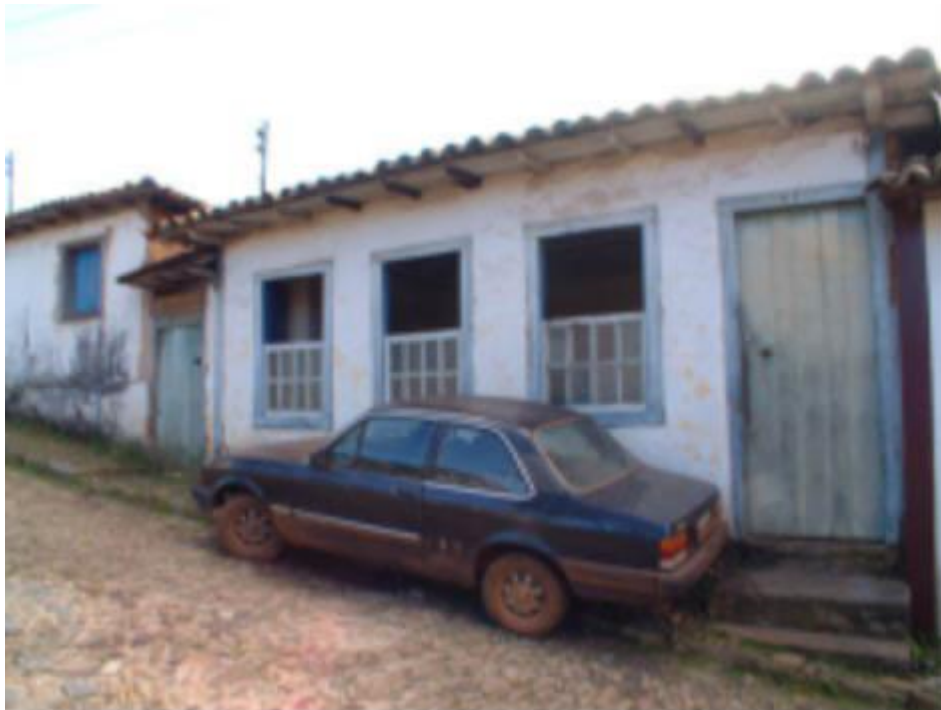
Figura 52: Fachada do Imóvel em 2002. Fonte: Inventário INBI-SU. Data: 12 abr. 2002.
