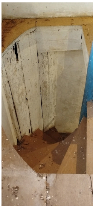
Figuras 63 e 64 –Escada para o coro da Capela de Santana deteriorada.
