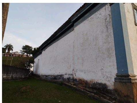
Figuras 66 e 67-Proliferação de microrganismos na base das paredes.
