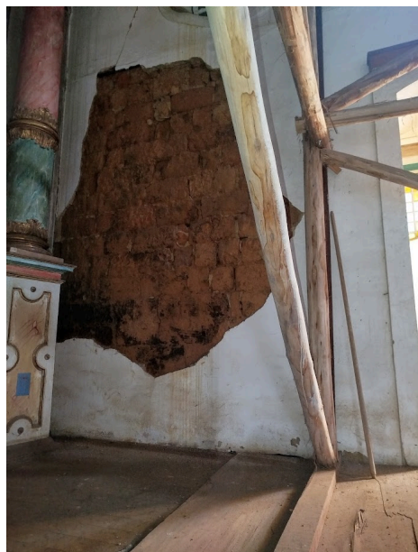
Figuras 76 e 77 –Adobe original exposto devido a desprendimento do reboco.
