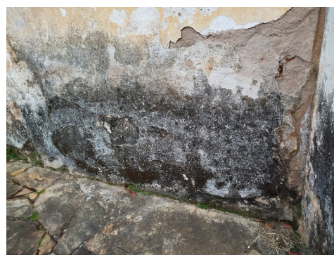
Figuras 66 e 67-Proliferação de microrganismos na base das paredes.
