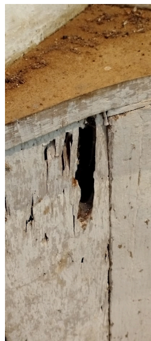
Figuras 63 e 64 –Escada para o coro da Capela de Santana deteriorada.
