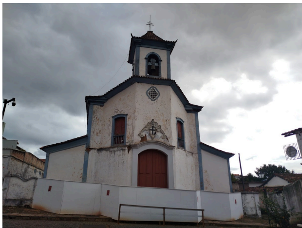
Figura 82- Tapumes na fachada da Capela Rainha dos Anjos.
