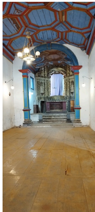
Figuras 55 e 56- Forro em caixotões da nave da Capela de Santana.
