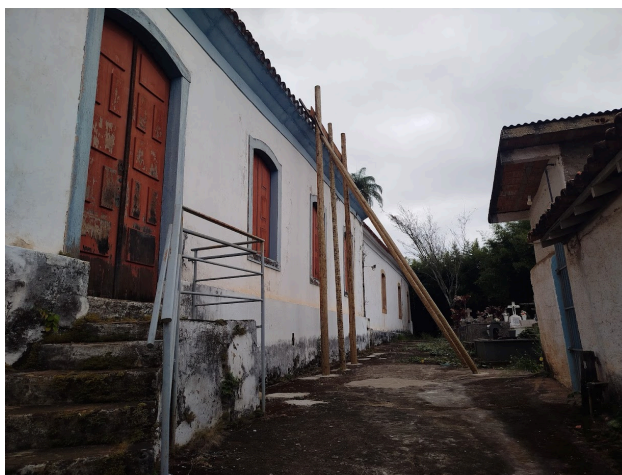
Figura 84 -Escoramento das paredes da Capela Rainha dos Anjos.
