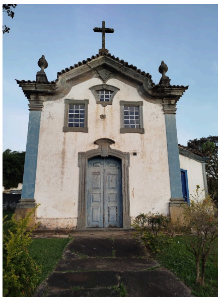
Figura 18– Fachada principal da Capela de Santana, Mariana-MG.
