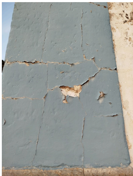
Figuras- 68 e 69- Danos nas paredes da Capela de Santana.
